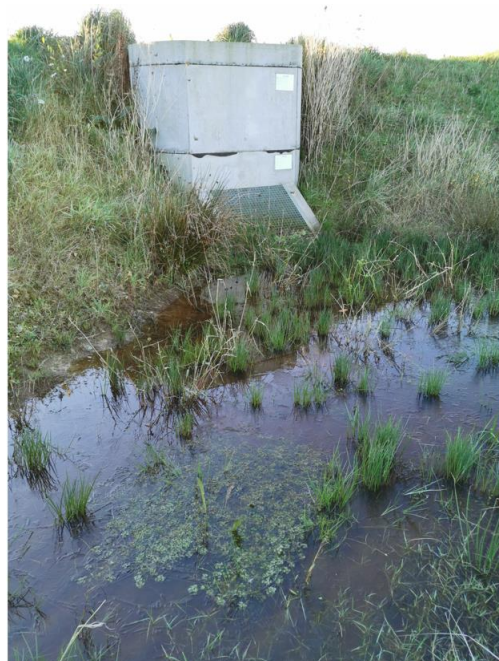
Photo 11 : zone humide au droit de l'ouvrage de régulation (nov. 2021)
