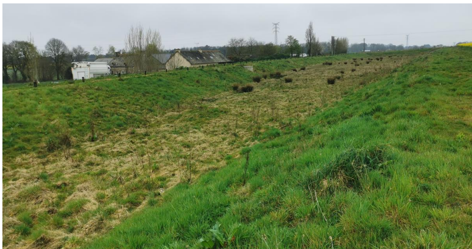
Photo 4 : bassin tampon, vue d'ensemble depuis l'Est (mars 2022)
